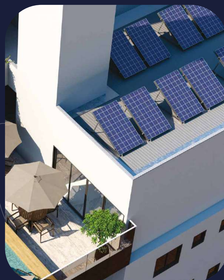
Painéis solares para aquecimento de água
